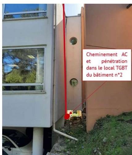
Figure 12 - Percement en façade du bâtiment n°2
