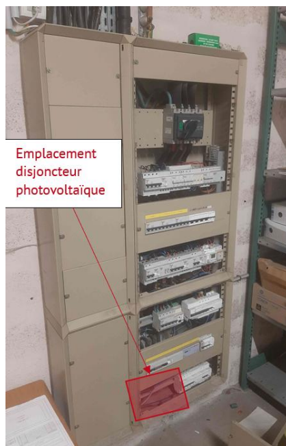
Figure 6 – Visuel du TGBT bâtiment n°3
