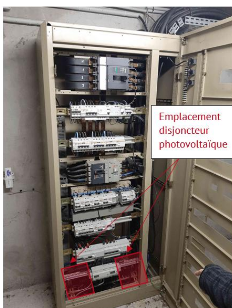
Figure 5 – Visuel du TGBT bâtiment n°2
