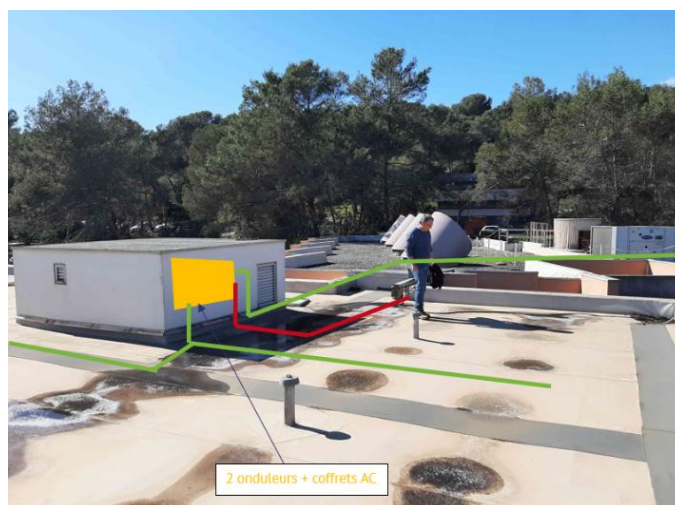
Figure 3 - Fixation des équipements de la toiture du bâtiment n°2 sur l'édicule Nord
