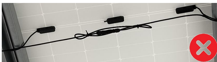
Figure 9 - Exemple de câblage à ne pas réaliser .
